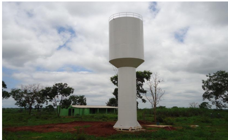
Figura 2: Perfuração do poço e instalação de reservatório de 30 mil litros. Assentamento 20 de Março, Três Lagoas/MS
