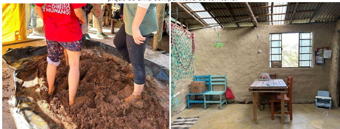
Imagem 6 : Atividades da Visita do CRATerre e USP. À esquerda, atividade de preparação do barro para construção de parede em pau-a-pique no lote 11, onde reside um dos companheiros e à direita, imagem interna da casa feita em pau-a-pique de uma companheira do território.
